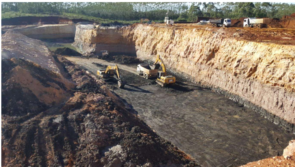
Figura 11: Desmonte mecânico e carregamento da camada de carvão em caminhões basculantes.
