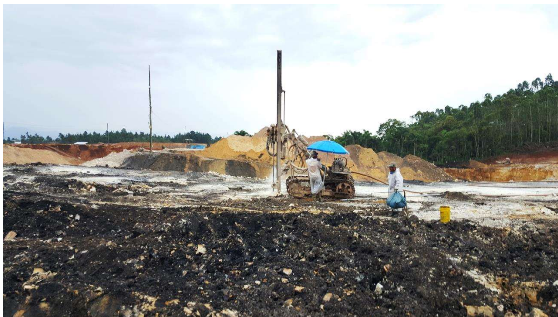
Figura 8: Perfuração do banco de arenitos de cobertura para desmonte com utilização de explosivos.
